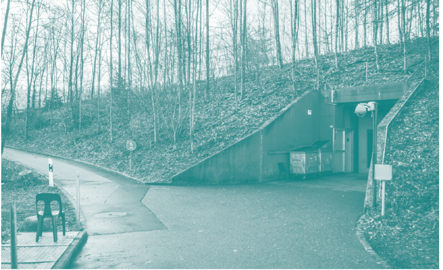
Ort der Hoffnungslosigkeit: Eingang zum Nothilfe-Bunker in Urdorf.
